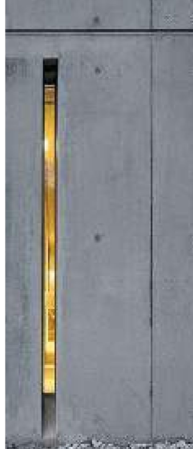
Betonkerne med lys/vinduesspalter
