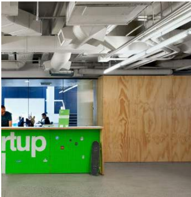
Rå industrielle rum med synlig ventilation
