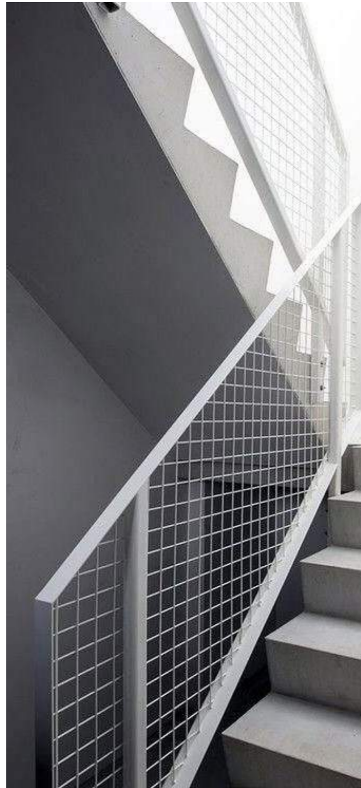
Lette metalværn ved atrium
